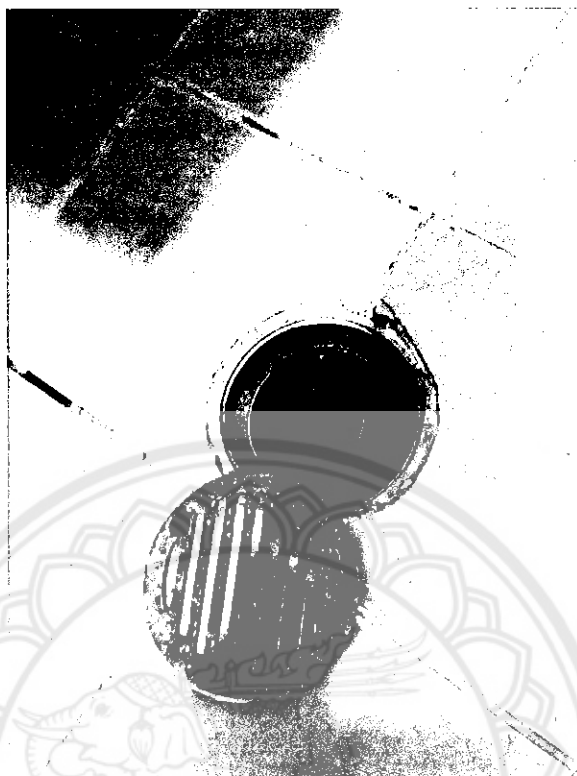
รูปที่ 4.18 ภาพของ flood rain ที่ชำรุด ไม่สามารถกันกลิ่นได้
