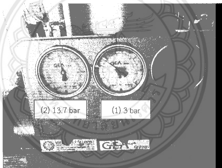
รูปที่ 4.8 ค่าความดันที่อ่านได้จริงจากคอมเพรสเซอร์ในสภาวะที่ (1) และ (2)
