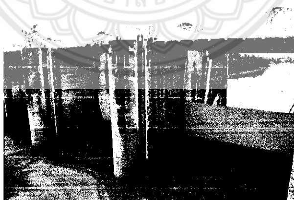
รูปที่ 2.7 ประตูน้ำบานสี่เหลี่ยมรูปโค้ง [25]
