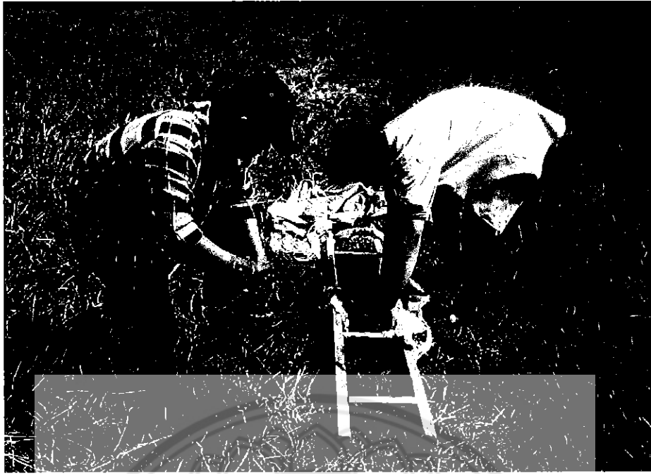
รูปที่ 16 แสดงการเทดินลงแบบ
