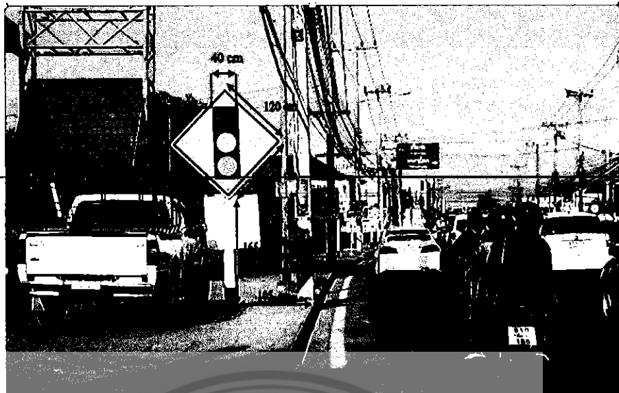
รูปที่ ผก-9 แสดงขนาด ความสูง และระยะห่างจากไหล่ทางของป้าย แยกบ้านคลอง
