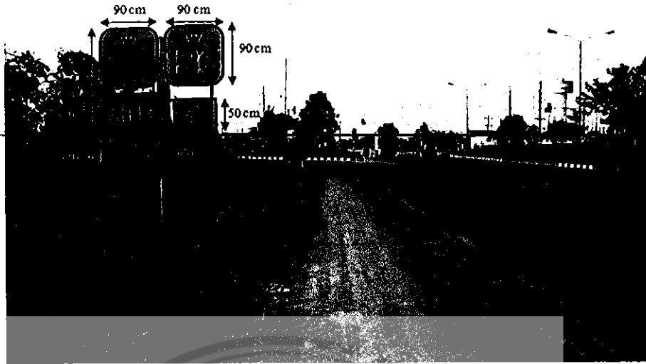
รูปที่ ผก-3 แสดงขนาด ความสูง และระยะห่างจากไหล่ทางของป้าย แยกหนองอ้อ
