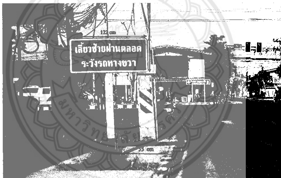
รูปที่ ผก-10 แสดงขนาด ความสูง และระยะห่างจากไหล่ทางของป้าย แยกบ้านคลอง
