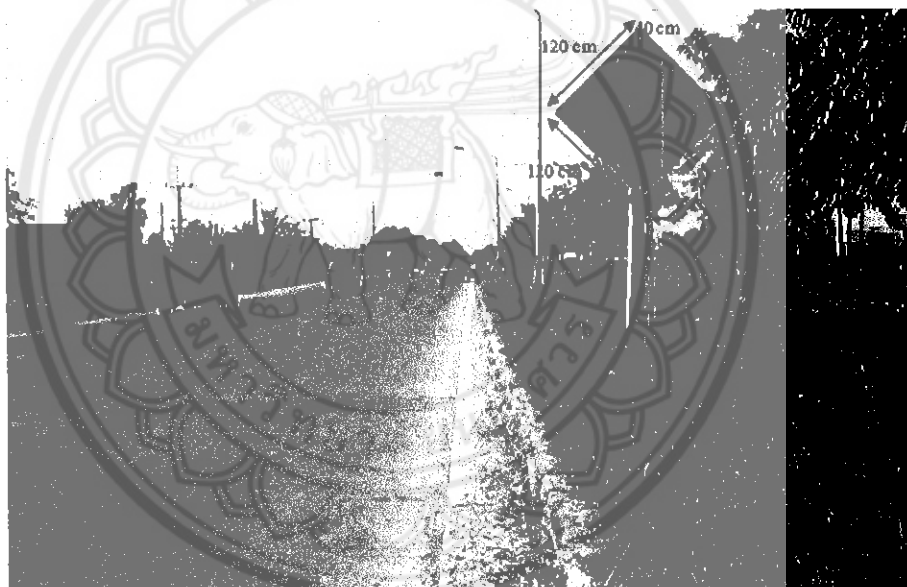
รูปที่ ผก-4 แสดงขนาด ความสูง และระยะห่างจากไหล่ทางของป้าย แยกหนองอ้อ
