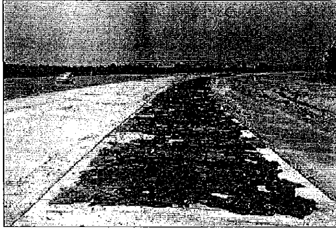
รูปที่ 2.25 วิธีการบ่มคอนกรีตด้วยกระสอบเปียก
