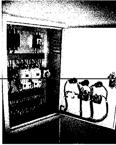
รูปที่ 3.17 ตู้ควบคุมชุดปรับแรงดันไฟฟ้า
