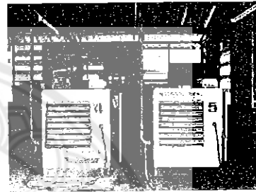
รูปที่ 2.8 การติดตั้งเครื่องอัดอากาศที่มีการทำ การทำความร้อนทิ้งออกห้อง
