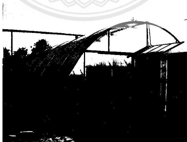
รูปที่ 3.1 โรงอบกล้วยตากพลังงานแสงอาทิตย์แบบกรีนเฮาส์
