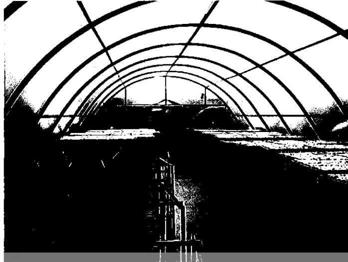
รูปที่ 2.9 ลักษณะภายในโรงอบกล้วยตากพลังงานแสงอาทิตย์แบบกรีนเฮาส์
