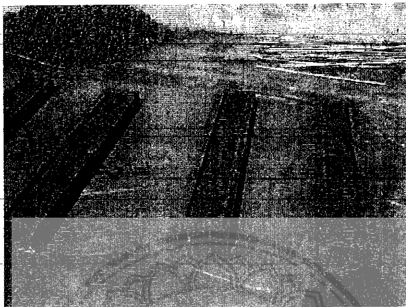
รูป 3.27 การตักเสานำทางทิ้งไว้เพื่อให้แห้งและสามารถถอดออกจากแบบได้เมื่อเวลาผ่านไปประมาณ 1 วัน เนื่องจากการหดตัวของเสานำทาง
