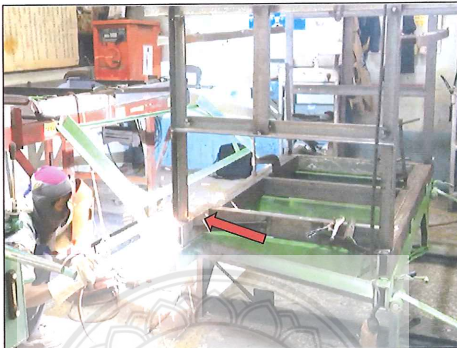
รูปที่ 4.60 เชื่อมเสาชองแผงข้างอีกรอบ
