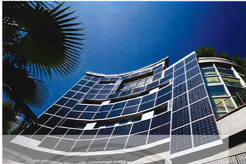
ภาพ 9 ระบบเซลล์แสงอาทิตย์แบบเชื่อมต่อเข้าสายส่งที่ติดตั้งร่วมกับอาคาร
