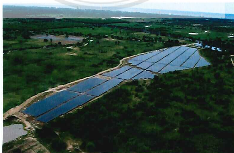
ภาพ 7 โรงไฟฟ้าเซลล์แสงอาทิตย์ขนาดใหญ่ จังหวัดเพชรบุรี
