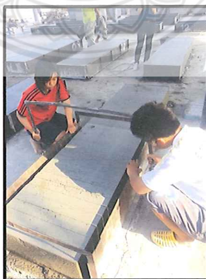
รูปที่ 2.1 การตัดอิฐมวลเบาแบบตัดเป็ยก
