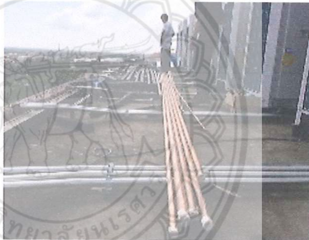
รูปที่ 2.15 การจัดเก็บท่อทองแดงที่ถูกต้อง ปิดหัวท้าย และไม่วางสัมผัสกับคอนกรีตโดยตรง
