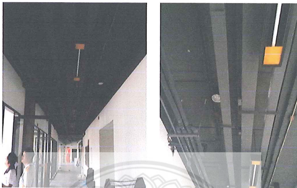
รูป ก 6 การเดินท่อสารทำความเย็นภายใน
