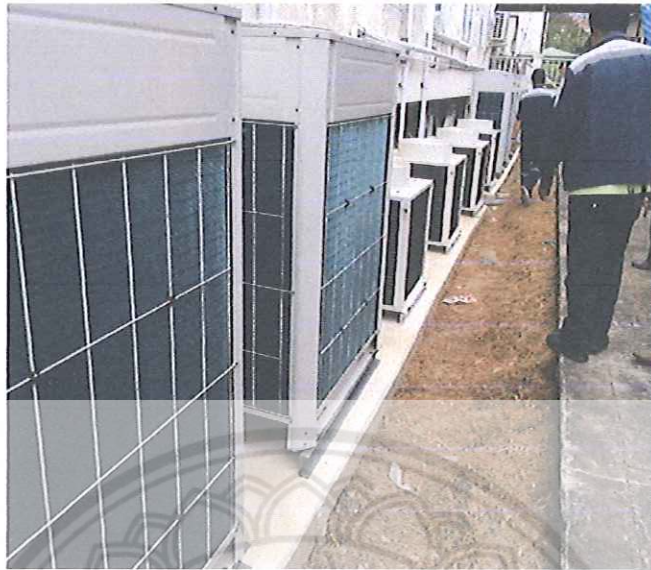
รูป ก 1 ชุด Condenser บนพื้นที่ข้างตัวอาคาร
