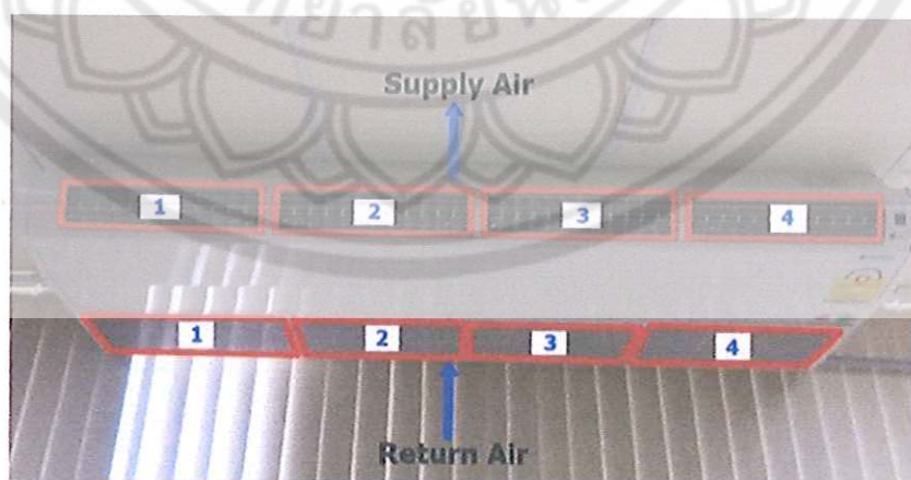
รูปที่ 2.13 แสดงการแบ่งพื้นที่ของอากาศกลับและอากาศจ่ายออกเป็น 4 ช่อง
