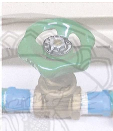
รูปที่ 3.6 โกลบวาล์วน้ำ รหัส : GV-15S ยี่ห้อ : SANWA รุ่น : GV-15S
