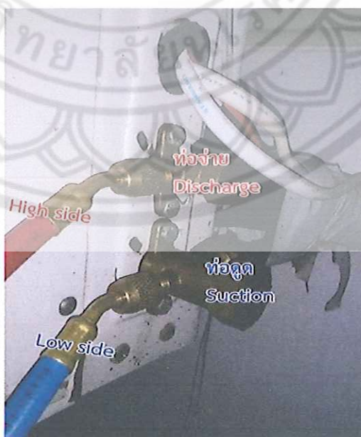
รูปที่ ก.18 แสดงการต่อสายแมนิโฟลด์เกจเข้ากับท่อดูดและท่อจ่าย
