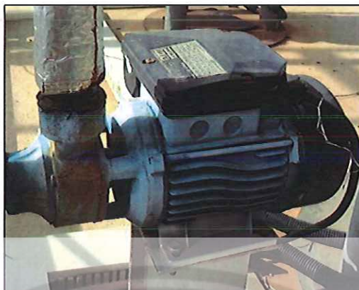
รูปที่ 20 ปั๊มน้ำหมุนเวียนระบบปั๊มความร้อน
