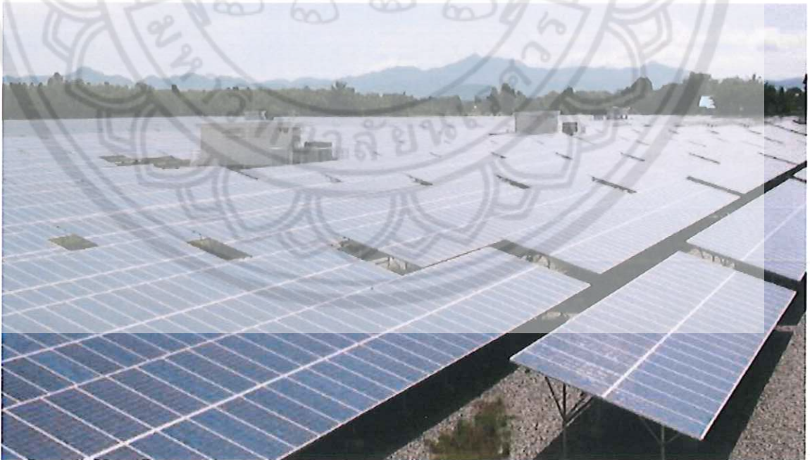
รูปที่ 3.10 แสดงการติดตั้งแผงเซลล์แสงอาทิตย์ในระดับ String เพื่อออกแบบวิธีการวัดค่า Insulation resistant
