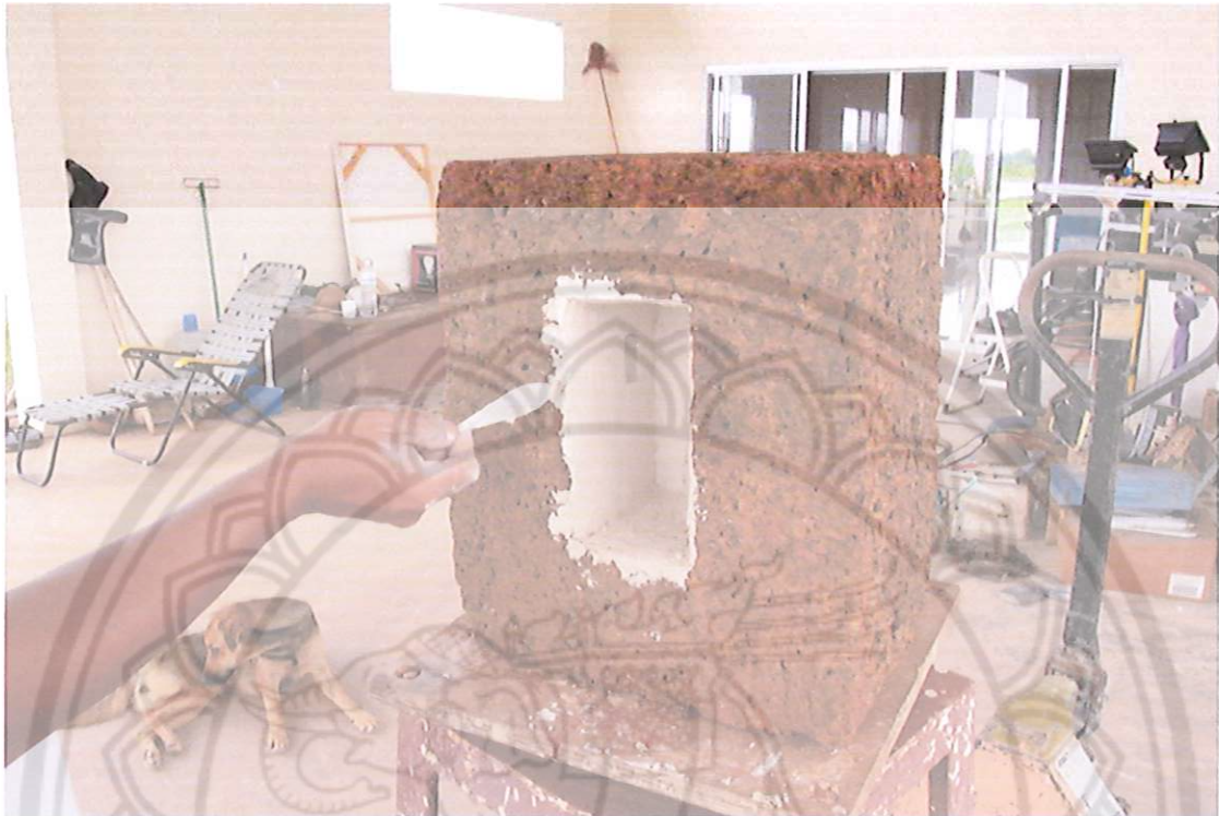
ภาพ 19 แสดงขั้นตอนการปั้นปูนเพื่อสร้างรูปทรงบนศิลาแลง (1)
