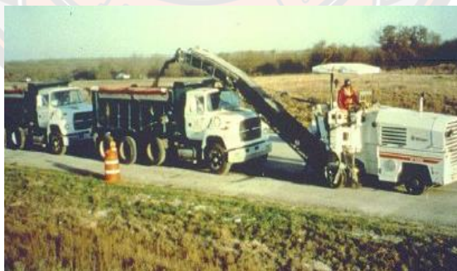
รูปที่ 3-6 การรื้อหรือตัดชั้นทางแอสฟัลต์คอนกรีตเดิมแบบเย็น (Cold Milling) ที่มา : สำนักวิเคราะห์และตรวจสอบ (2555)
