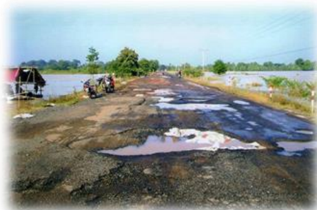
รูปที่ 2-7 ผิวทางชำรุดจากอุทกภัย
