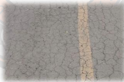
รูปที่ 2-6 รอยแตกบนผิวทาง (Crack) ประเภทรอยแตกจระเข้
