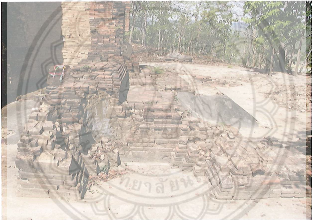
ภาพที่ 29 ภาพแสดง ระเบียบการก่ออิฐ การเชื่อมต่อผนังอาคารของปรารงค์ปู่จ่า อำเภอกีร์รีมาศ จังหวัดสุโขทัย (ที่มาของภาพ : ภาพถ่ายโดย นายอนันต์พงษ์ ไกรเกรียงศรี)
