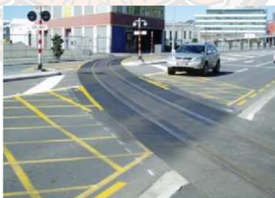
ภาพ 30 การข้ามรางรถไฟที่ถูกออกแบบมาดีมีแผ่นยางระหว่างราง เพื่อช่วยลดความเสี่ยงในการสูญเสียการควบคุมยานพาหนะ
