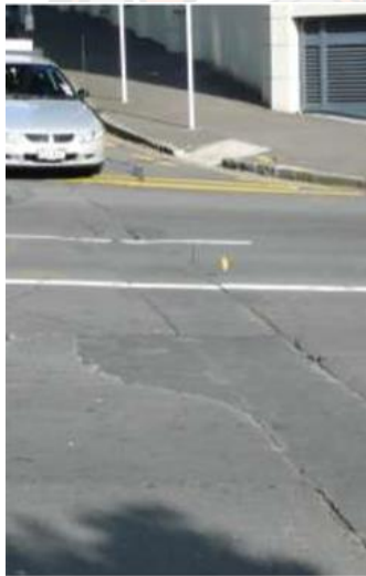
ภาพ 28 ท่อน้ำที่ฝังผ่านถนนเสื่อมสภาพและร้าวซึม ซึ่งเป็นอันตรายต่อผู้ใช้รถจักรยานยนต์
