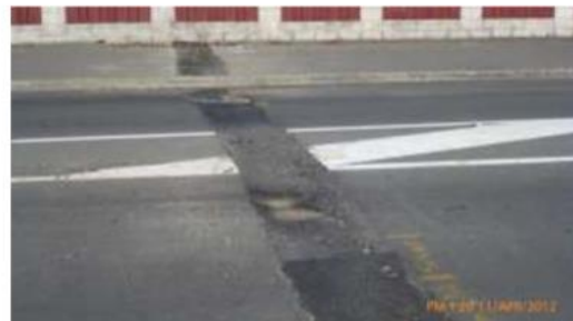
ภาพ 28 ท่อน้ำที่ฝังผ่านถนนเสื่อมสภาพและร้าวซึม ซึ่งเป็นอันตรายต่อผู้ใช้รถจักรยานยนต์
