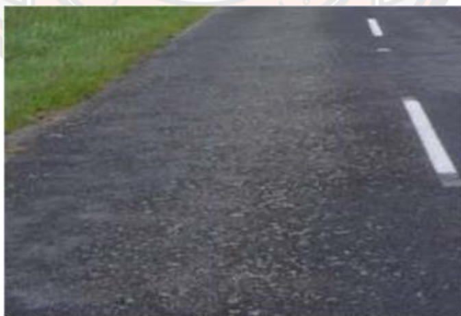
ภาพ 19 ตะไคร่น้ำที่ขึ้นบนผิวทางทำให้ผิวถนนลื่นและอันตรายต่อผู้ขับขี่รถจักรยานยนต์
