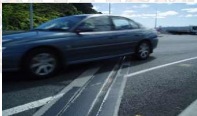
ภาพ 32 จุดเชื่อมต่อสะพานเป็นความเสี่ยงที่สำคัญต่อผู้ขับขี่รถจักรยานยนต์ โดยเฉพาะในพื้นที่ที่ต้องมีการเบรกหรือเข้าโค้ง
