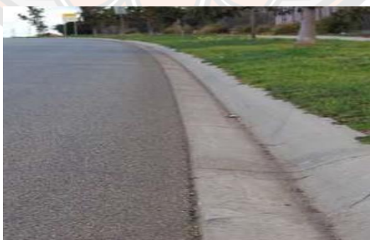
ภาพ 36 Semi- or fully mountable kerbing ช่วยโอกาสที่จะเกิดอุบัติเหตุ สำหรับผู้ขับขี่รถจักรยานยนต์
