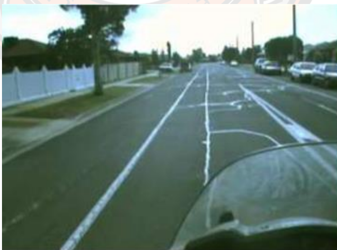
ภาพ 21 การปิดรอยแตกที่มีขนาดใหญ่อันตรายต่อผู้ขับขี่รถจักรยานยนต์เมื่อผิวถนนเปียก โดยเฉพาะการเบรกหรือการเข้าโค้ง
