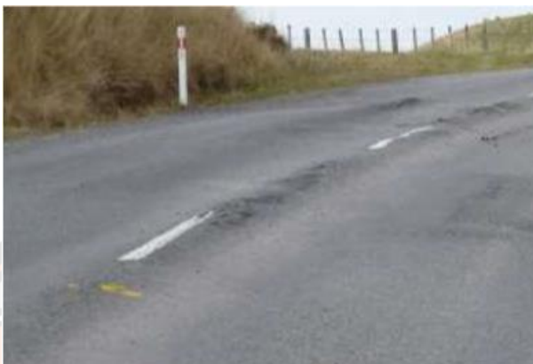
ภาพ 20 ร่องและรอยยูนอาจทำให้ผู้ขับขี่รถจักรยานยนต์สูญเสียความมั่นคงและการควบคุม โดยเฉพาะในทางโค้ง
