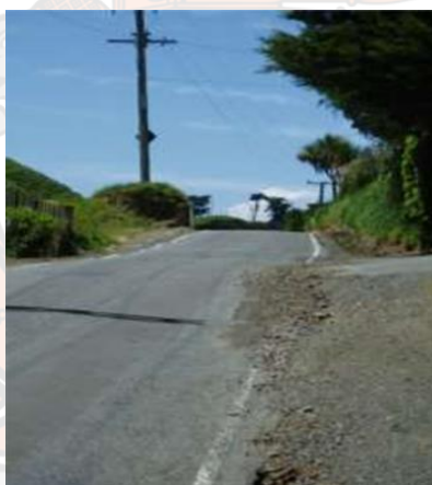
ภาพ 15 กรวดและหินที่หลุดหลวมจากไหล่ทางที่ไม่ได้เทผิวทาง อันตรายต่อผู้ขับขี่รถจักรยานยนต์
