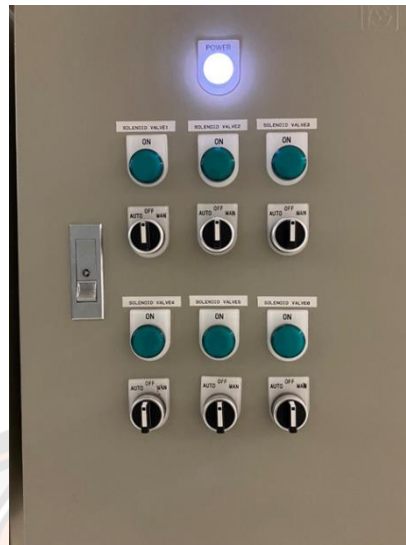
ภาพ 21 ลักษณะของตู้ควบคุมระบบจ่ายแก๊สคาร์บอนไดออกไซด์
