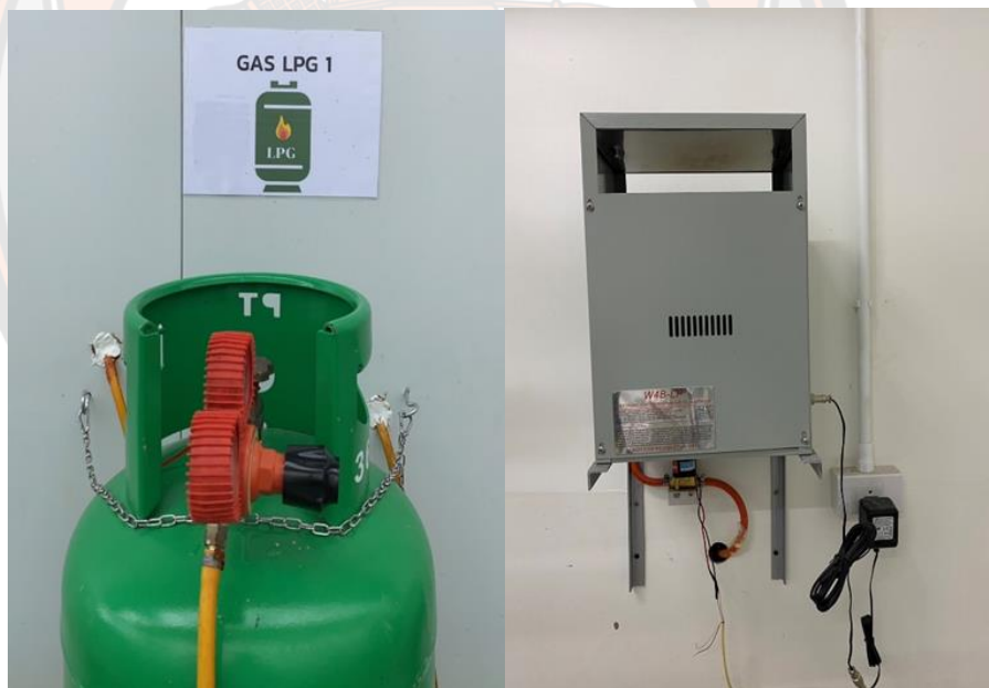
ภาพ 20 ลักษณะของระบบจ่ายแก๊สคาร์บอนไดออกไซด์
