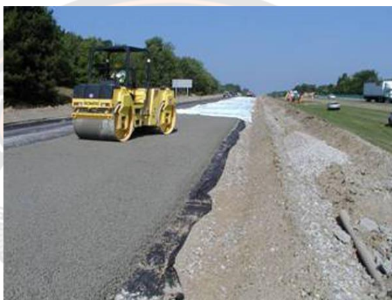
รูปที่ 2-6 การก่อสร้างชั้นทางปรับปรุงด้วยซีเมนต์
