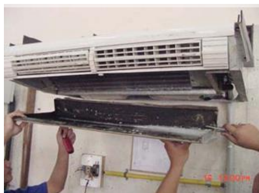
รูปที่ 2.10 การล้างถาดรองรับน้ำทิ้งและท่อน้ำทิ้ง
