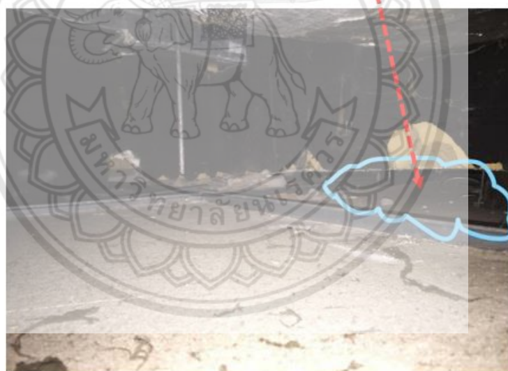
รูปที่ 4.3 ลักษณะของกล่องช่องลมกลับที่รอยต่อกับฝ้าเพดานรั่ว
