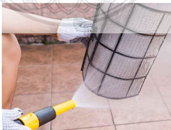
รูปที่ 2.7 การทำความสะอาดฟิลเตอร์
