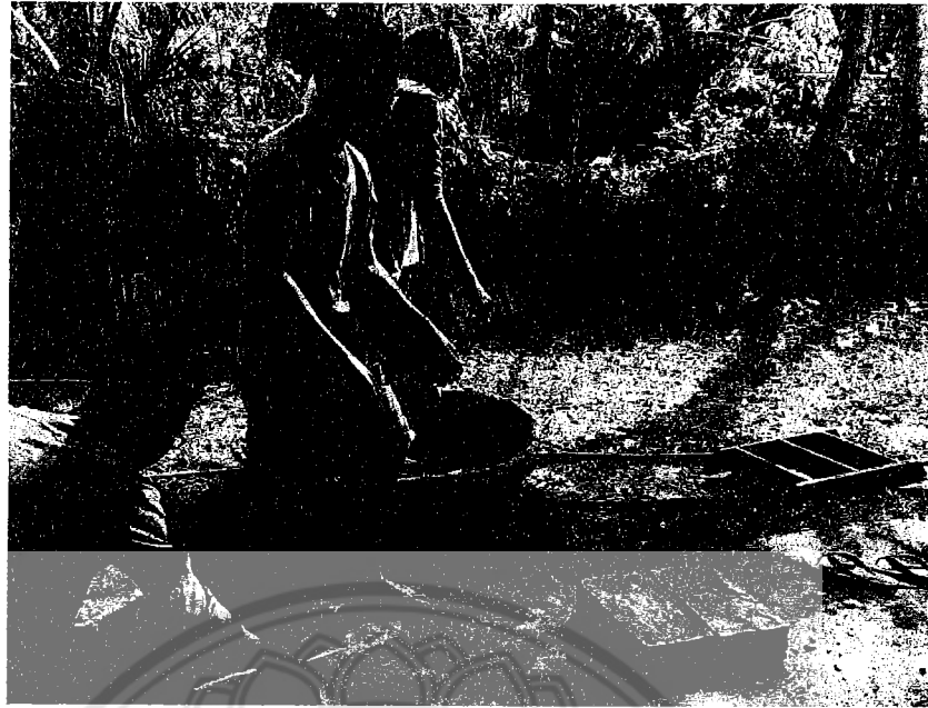
ภาพที่ 7 การย่ำดินเพื่อทำอิฐดินดิบ
