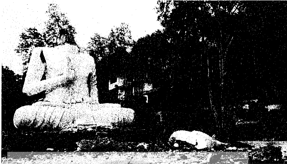
ภาพที่ 14 ความเสียหายของสิ่งปลูกสร้างจากเหตุการณ์แผ่นดินไหวที่อำเภอแม่ลาว ที่มา: www.thairath.co.th
