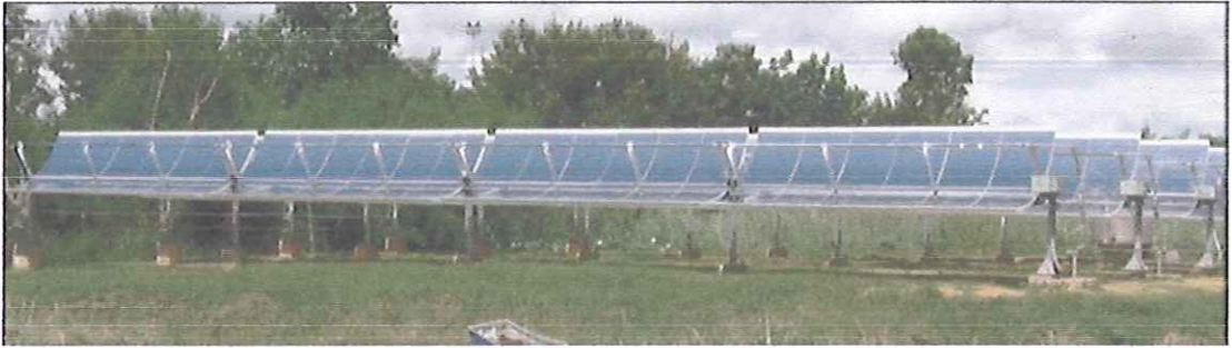
รูปที่ 1 ระบบผลิตไฟฟ้าพลังงานความร้อนแสงอาทิตย์ (แบบพาราโบลา) ร่วมกับระบบผลิตความร้อนชีวมวล ขนาด 10 กิโลวัตต์ ณ วิทยาลัยพลังงานทดแทน มหาวิทยาลัยนเรศวร
