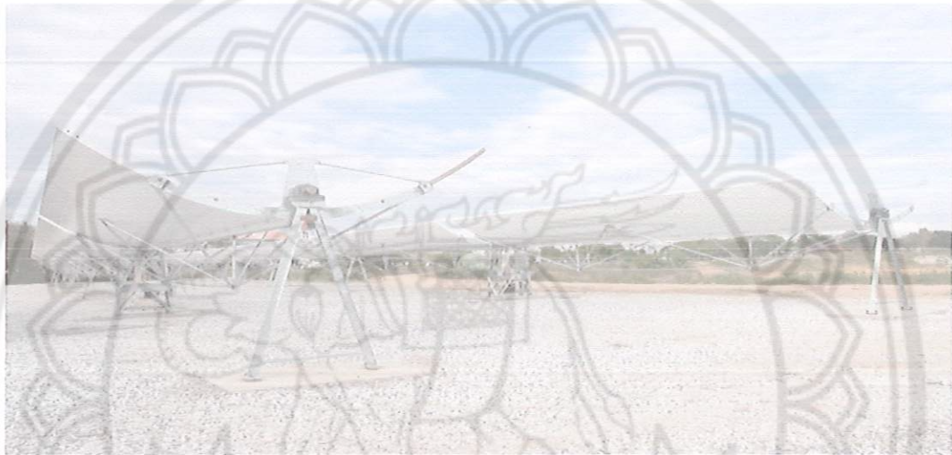
รูปที่ 2 ระบบผลิตไฟฟ้าพลังงานความร้อนแสงอาทิตย์ (แบบพาราโบลา) ร่วมกับระบบผลิตความร้อนชีวมวล ขนาด 25 กิโลวัตต์ ณ วิทยาลัยพลังงานทดแทน มหาวิทยาลัยนเรศวร
