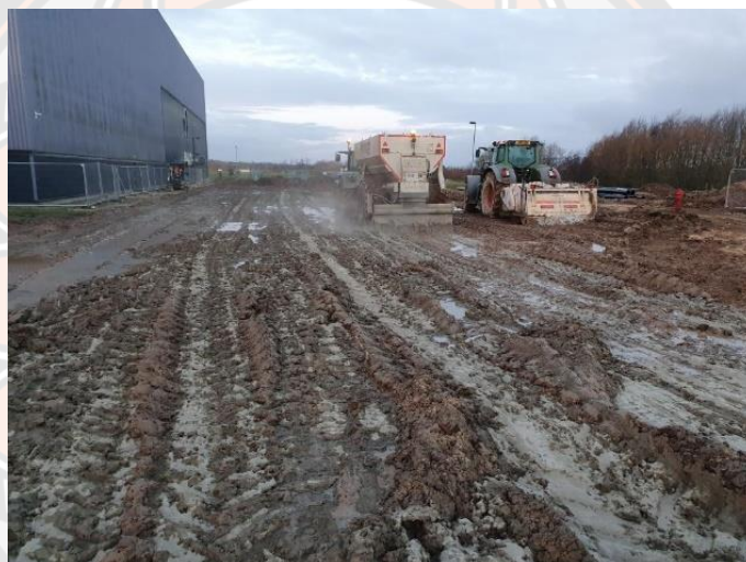
ภาพ 13 การเตรียมดินซีเมนต์ในสนามเพื่อใช้เป็นชั้นรองพื้นทาง [26]
