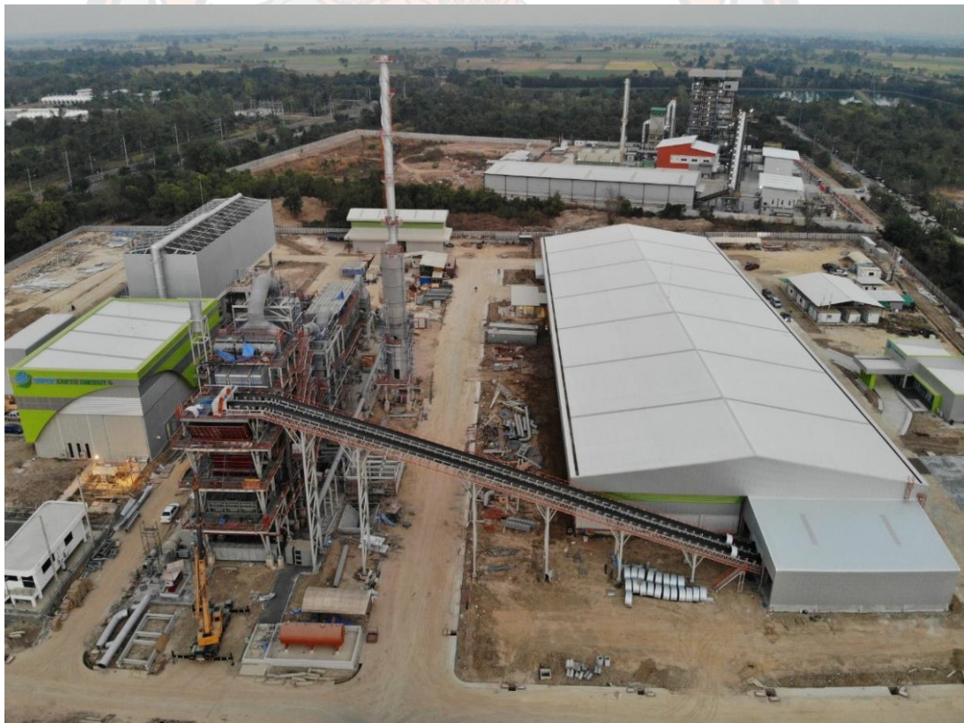
ภาพ 6 โรงไฟฟ้าเชื้อเพลิงขยะในงานวิจัยนี้
