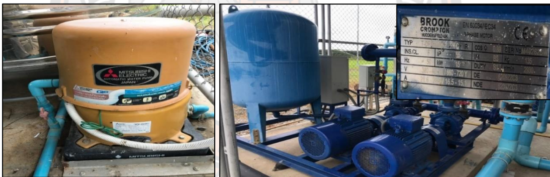
ภาพ 36 การดำเนินการติดตั้งปั้มน้ำขนาดเล็กแยกออกจากระบบปั้มน้ำล้างแผง PV
