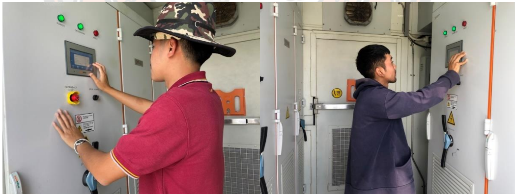
ภาพ 38 การดำเนินการเซ็ทค่า PF ในเครื่องอินเวอร์เตอร์ทุกตัวให้เท่ากับ 0.996 leading
