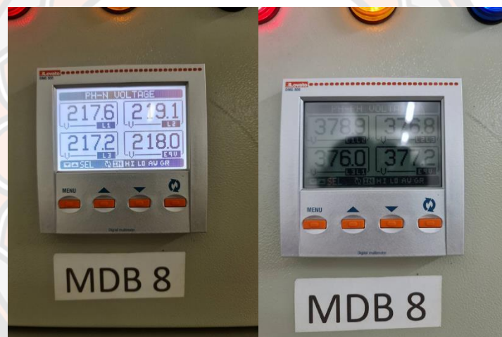
ภาพ 12 ภาพแรงดันไฟฟ้าด้าน Low voltage “หลัง” ทำการปรับ Tap changer
