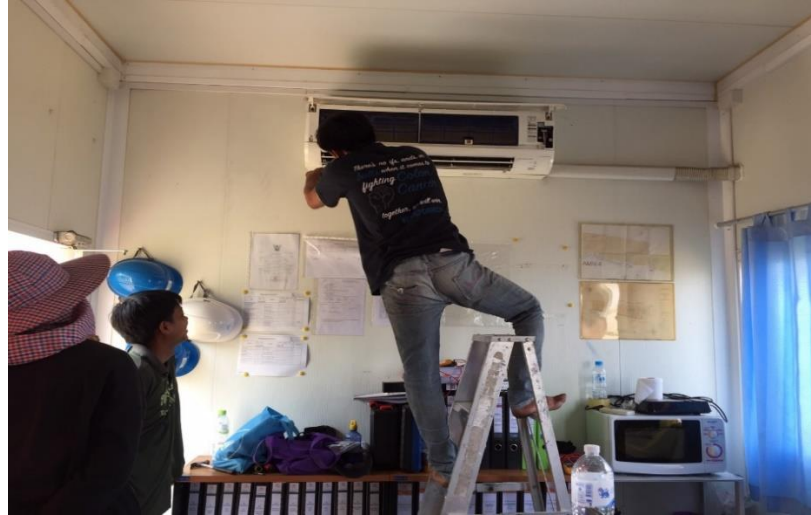
ภาพ 35 การดำเนินการล้างเครื่องปรับอากาศ
