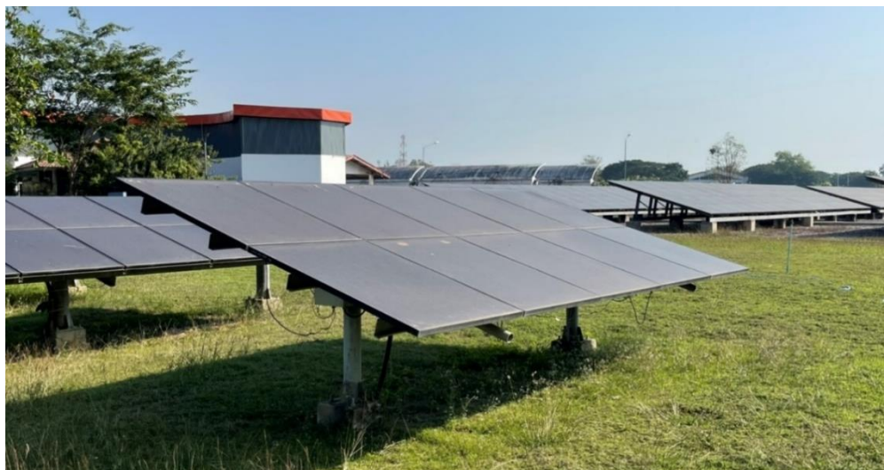
ภาพ 8 ระบบผลิตกระแสไฟฟ้าด้วยเซลล์แสงอาทิตย์ขนาด 1.2 กิโลวัตต์
