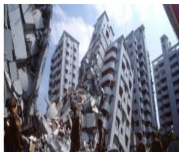
ภาพ 16 ตัวอย่างสถานการณ์ เรื่อง นักวิศวกรออกแบบโครงสร้าง
