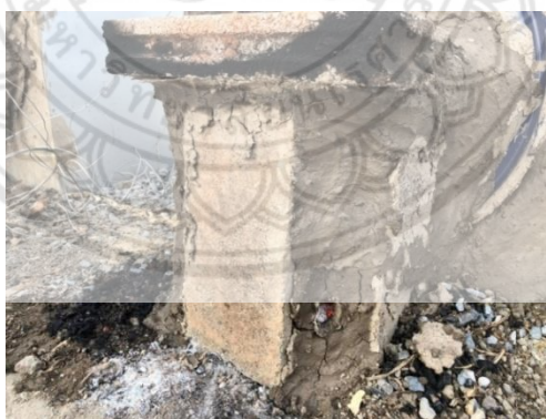
รูปที่ 3.13 วิธีการควบคุมอากาศของเตาแบบดั้งเดิม
