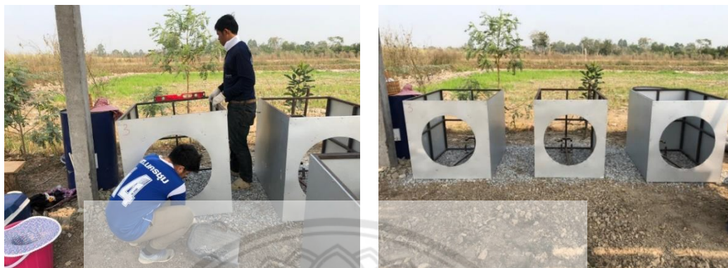
รูปที่ 4.32 การปรับหน้าดินและการวางโครงเตา ของเตาต้นแบบ
