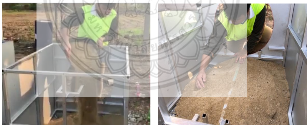
รูปที่ 4.33 การเททรายและปรับพื้นทราย ของเตาต้นแบบ
