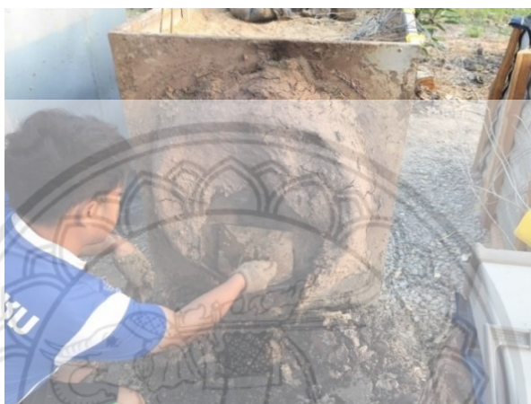
รูปที่ 3.22 การปิดหน้าเตาของเตาดั้งแบบ
