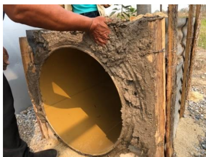
รูปที่ 3.6 การตัด ประกอบปล่อง และประสานรอยต่อด้วยดิน ของเตาแบบดั้งเดิม
