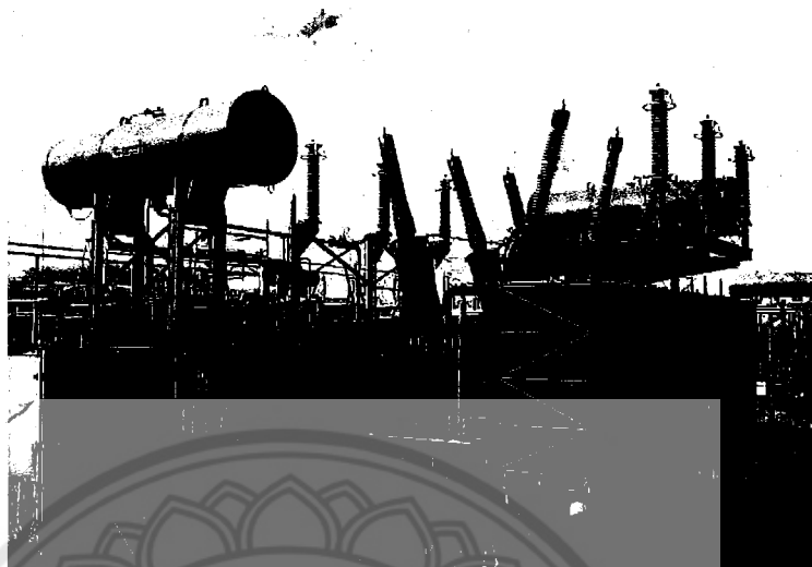
รูปที่ 2.24 หม้อแปลงแบบเลื่อนมุมเฟส [27]
