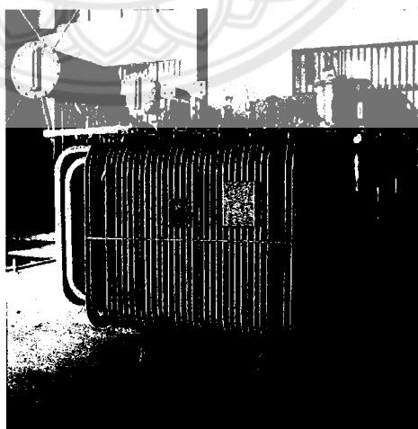
รูปที่ 2.23 หม้อแปลงแบบรักษาระดับเอาต์พุตให้คงที่ [26]
