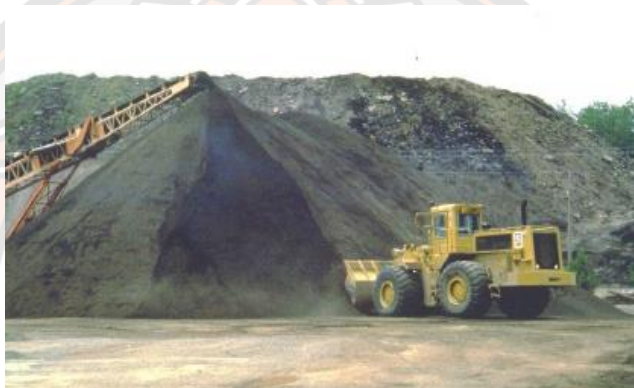
รูปที่ 2-12 การย่อยชั้นทางแอสฟัลต์คอนกรีตเก่า แล้วนำไปทำ Stock Pile (กรมทางหลวง, 2012)
