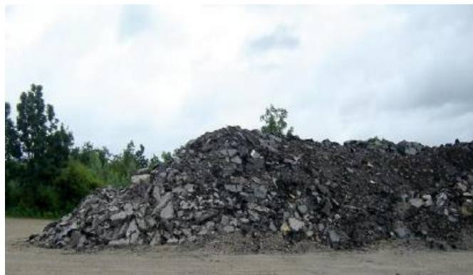
รูปที่ 2-10 การรื้อหรือตัดชั้นทางแอสฟัลต์คอนกรีตเก่าโดยวิธี Ripping (กรมทางหลวง, 2012)
