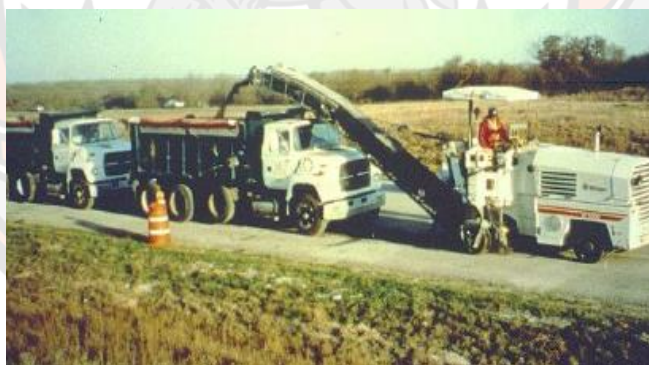
รูปที่ 2-11 การรื้อหรือตัดชั้นทางแอสฟัลต์คอนกรีตเก่าแบบเย็น (Cold Milling) (กรมทางหลวง, 2012)
