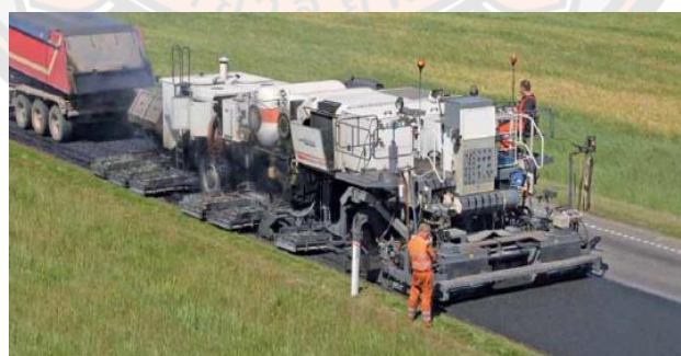
รูปที่ 2-14 เครื่อง Re-mixer (จาก Wirtgen GmbH) (กรมทางหลวง, 2012)
