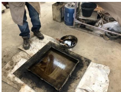
รูปที่ 3-65 เตรียมแบบหล่อสำหรับขึ้นแผ่นแอสฟัลต์คอนกรีต
