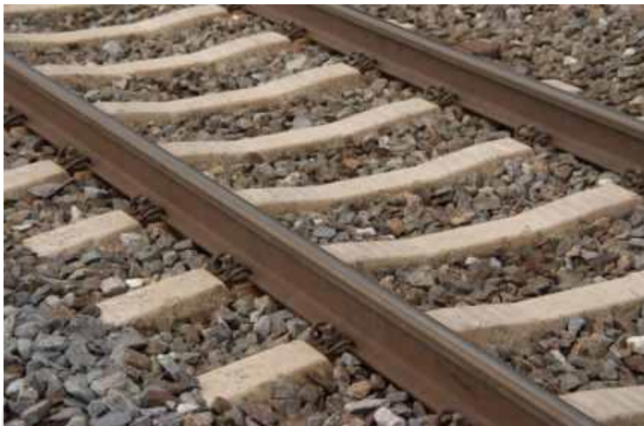
ภาพ 3 ทางรถไฟแบบใช้หินโรยทาง
