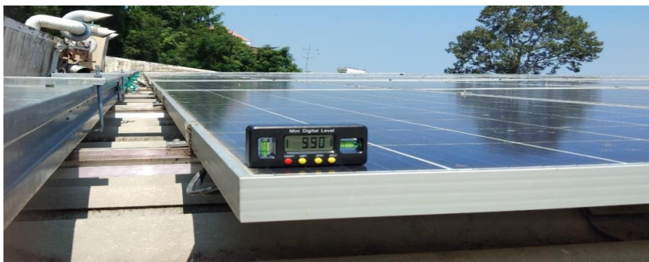
(a) อาคาร A
