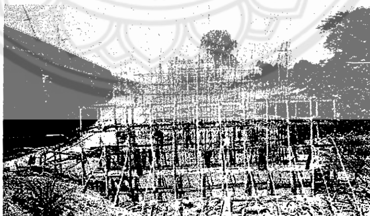
รูปที่ 33. ภาพแสดงการผูกเหล็กที่บริเวณลำน้ำ
