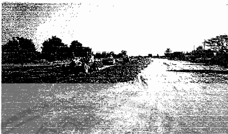
รูปที่ 4.การเกลี่ยแต่งและบดทับให้ได้แนว ระดับ และรูปร่างตามแบบ
