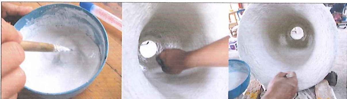
ภาพ 64 ทาผิวด้วยผงแคลเซียมผสมน้ำและกาวทับบนผิวปูนด้านในหนึ่งชั้นงาน
