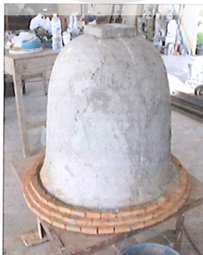
ภาพ 53 แสดงการก่ออิฐบนรูปทรงจากส่วนล่างไปสู่ด้านบน
