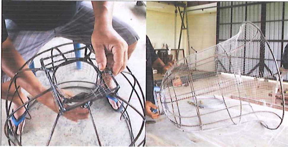
ภาพ 51 การติดตะแกรงเหล็ก (Chicken Wire)
