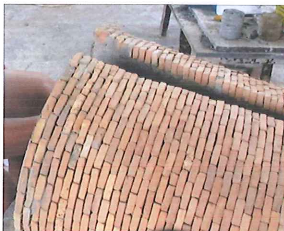
ภาพ 56 ก่ออิฐเต็มพื้นผิวภายนอกของรูปทรง
