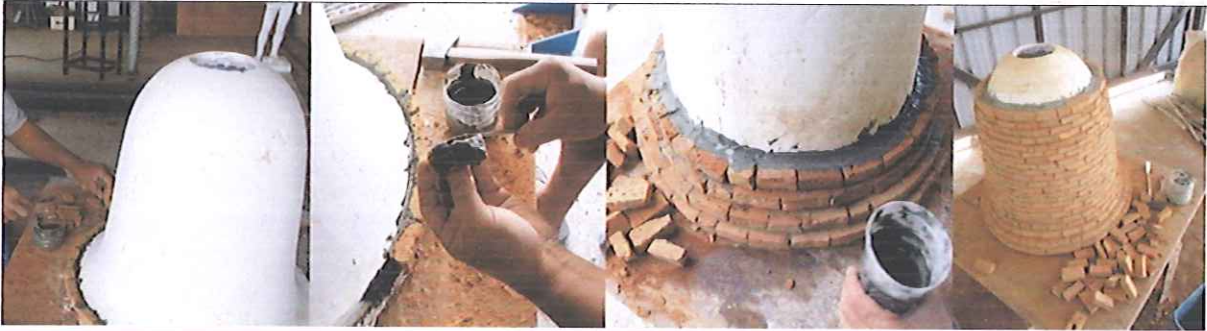
ภาพ 62 การก่ออิฐจากฐานสู้อยอดของรูปทรง
