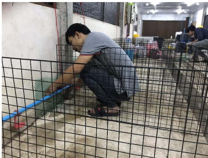
ภาพ 20 การเตรียมความพร้อมเชิงระบบการให้น้ำอัตโนมัติแบบหัวหยด (nipple)
