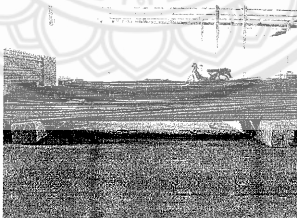
รูปที่ 4.10 แสดงการจับเก็บที่ถูกต้องของเหล็ก
