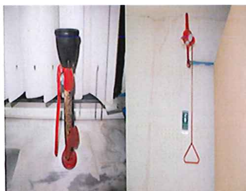
ภาพ 1.3 อ่างล้างตาและที่ล้างตัวฉุกเฉิน
