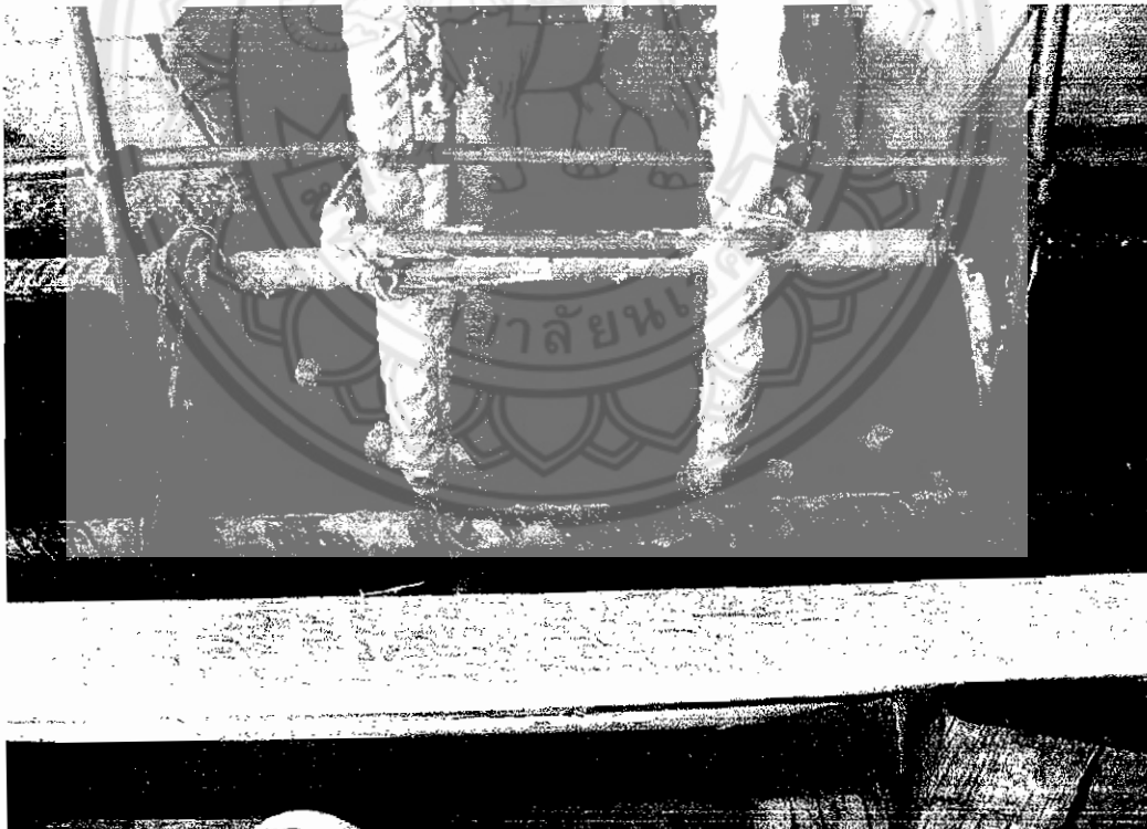
รูปที่ ข.35 แสดงการผูกเหล็กเสริมบริเวณรอยต่อที่มีลักษณะเป็นรูปตัวที (ต่อ)
