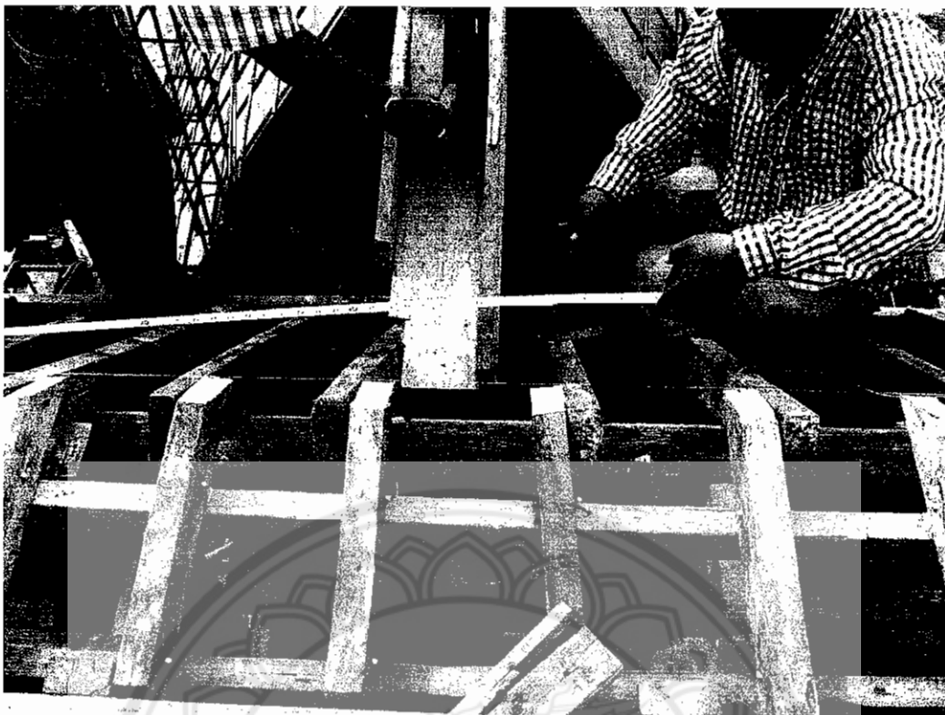
รูปที่ ข.26 แสดงการวางแบบหลังคา
