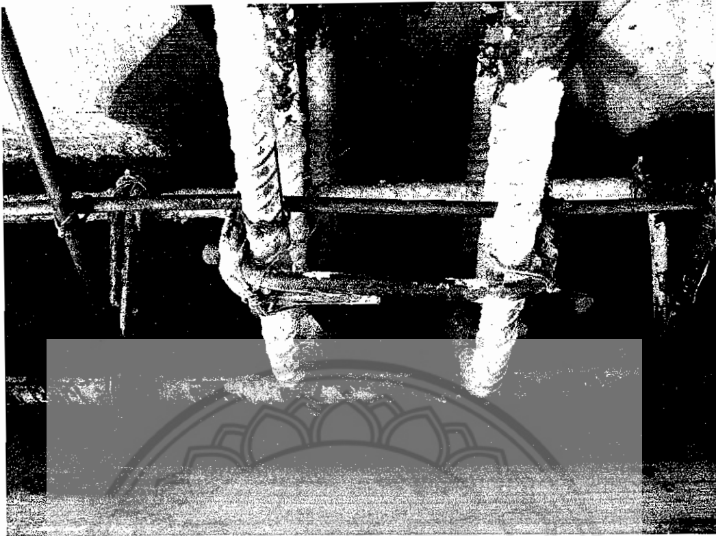
รูปที่ ข.34 แสดงการผูกเหล็กเสริมบริเวณรอยต่อที่มีลักษณะเป็นรูปตัวที
