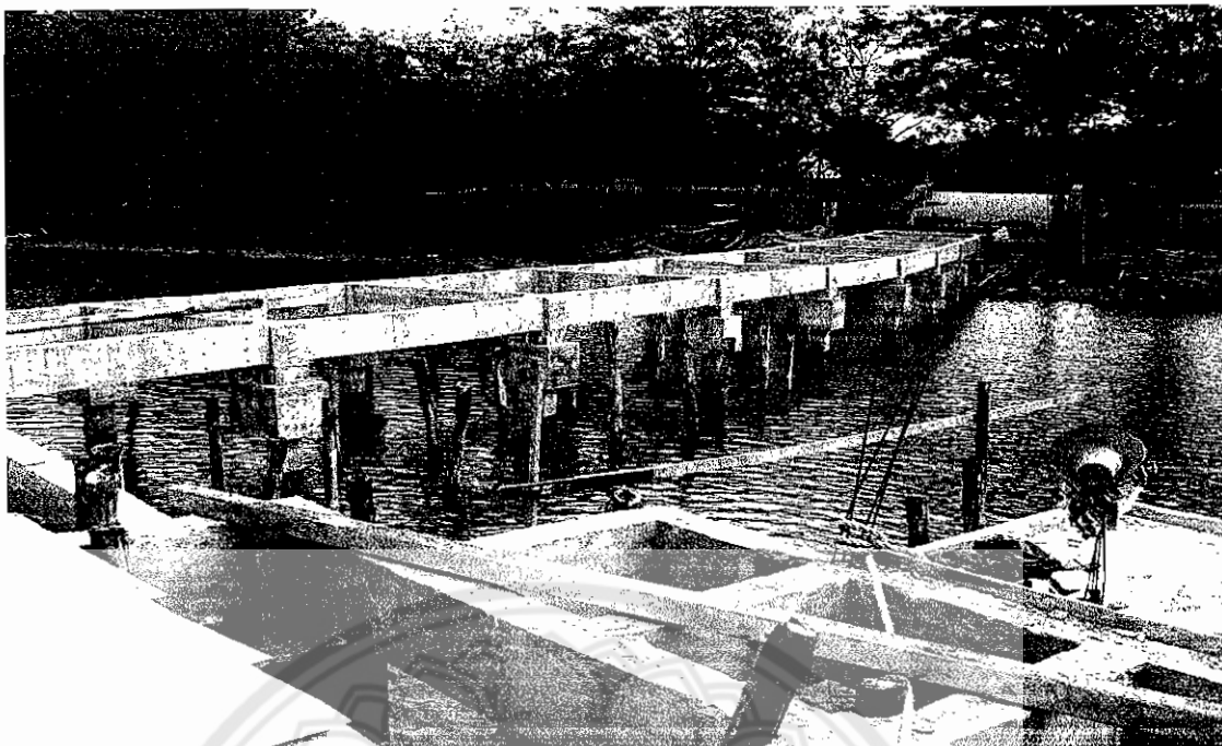
รูปที่ 3.5 กานบริเวณทางเดิน
