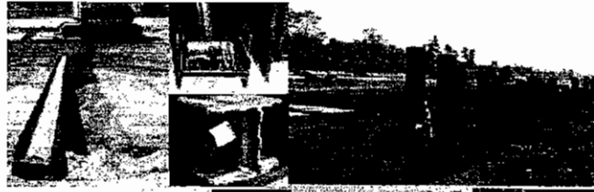
ค. เส้าเข็มเจาะเสียบ (Pre-auger driving pile)
