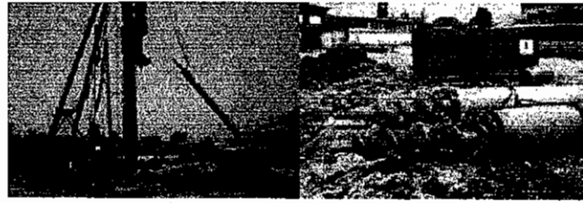
ค. เส้าเข็มเจาะเสียบ (Pre-auger driving pile)
