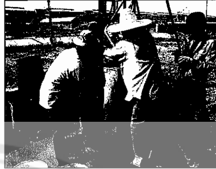
รูปแสดงการติดตั้งท่อ (Inclinometer Access Tube)
