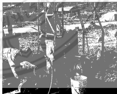
รูปแสดงการติดตั้งท่อ (Inclinometer Access Tube)
