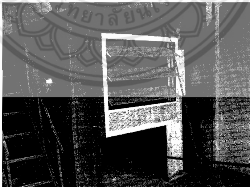
รูปที่ 3.3 บานเกร็ดสแตนเลสที่ติดตั้งหน้าเตาเผา
