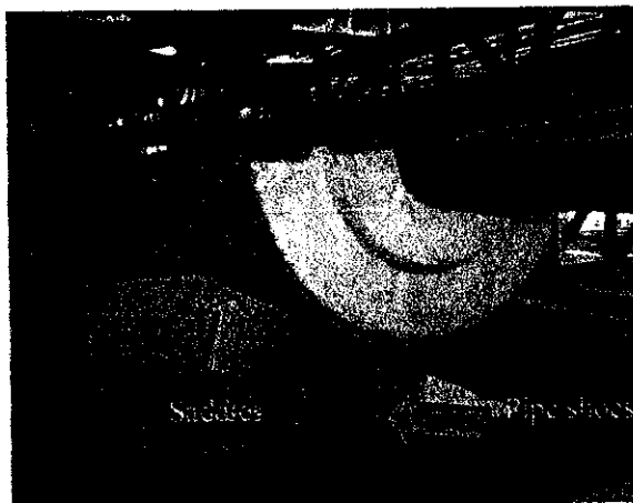
รูปที่ 3.3 แท่นรองรับท่อ (Pipe shoes) และแซคเคิลล์
