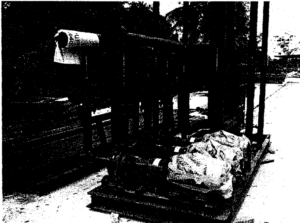
ข) รูปแสดงการติดตั้งอุปกรณ์ที่เครื่องสูบน้ำในช่วง Water side
