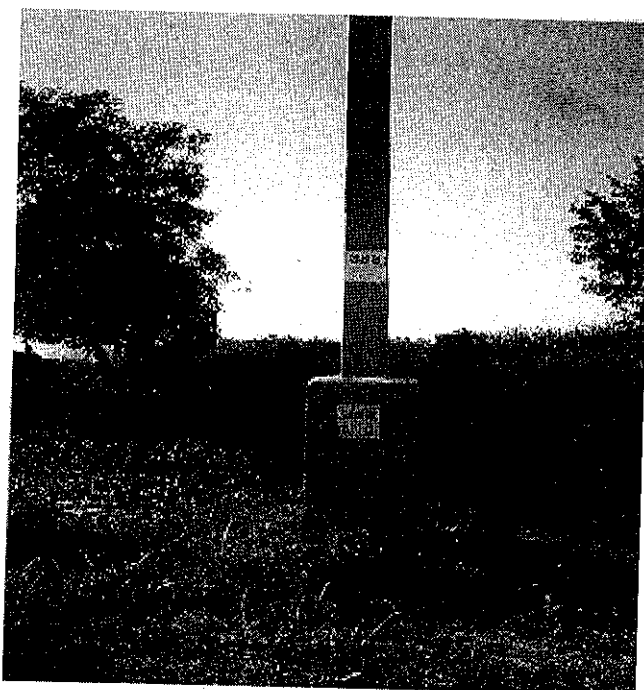
รูปที่ ค.5 เสาไฟฟ้าฐานรากค้ำริมถนนหมายเลข 117
