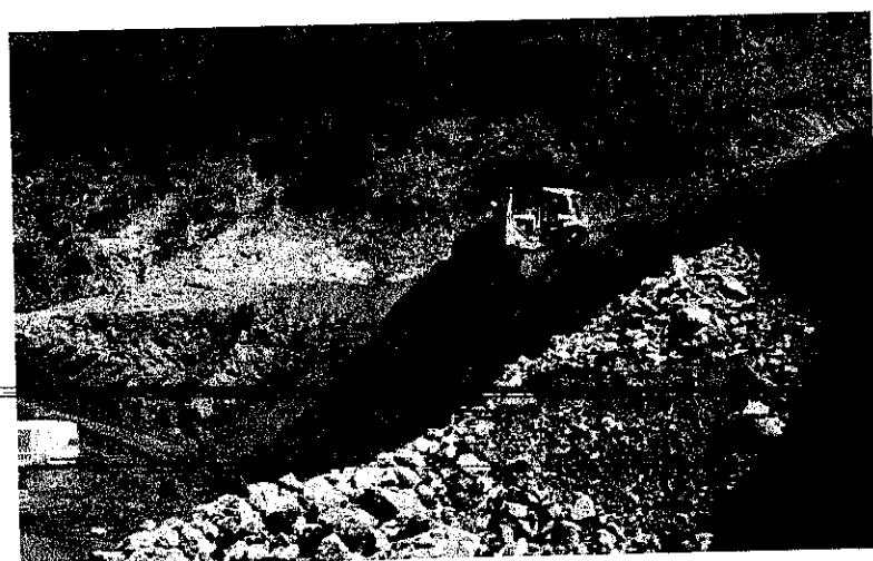
รูปที่ 16 ขนาดของหินที่ใช้ในการเรียงภายในกล่องขนาดตั้งแต่ 12 ซม. - 20 ซม.
