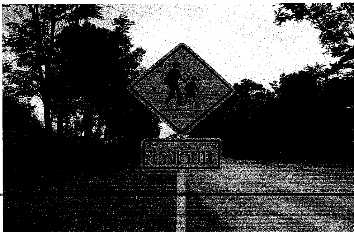
งานติดตั้งป้ายเตือน ทางหลวงหมายเลข 1090(ต่อ) ตอน อุ้มผาง - บ.ปะละทะ - กะแงคี (กม.34)
