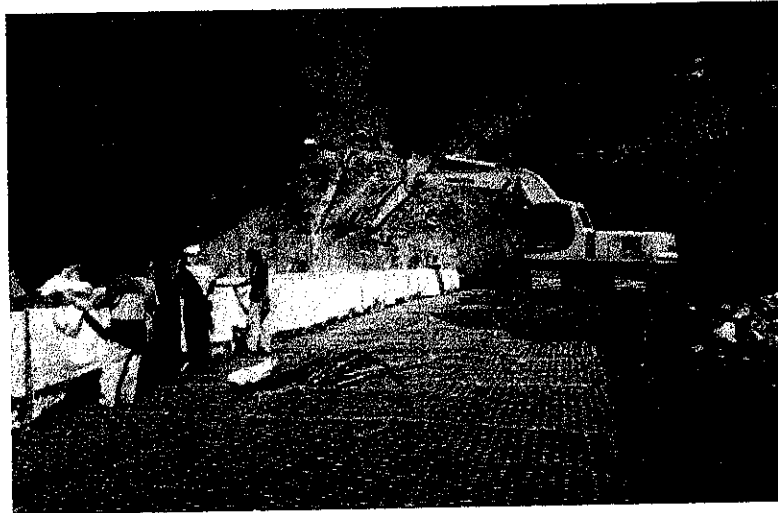
รูปที่ 17 วิธีการปูแผ่น Geotextile และการวางแผ่น Wire Mesh
