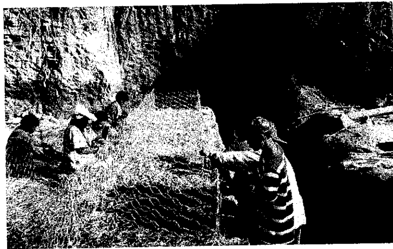
รูปที่ 14 วิธีการผูกกล่อง Gabion เป็นชั้นๆ
