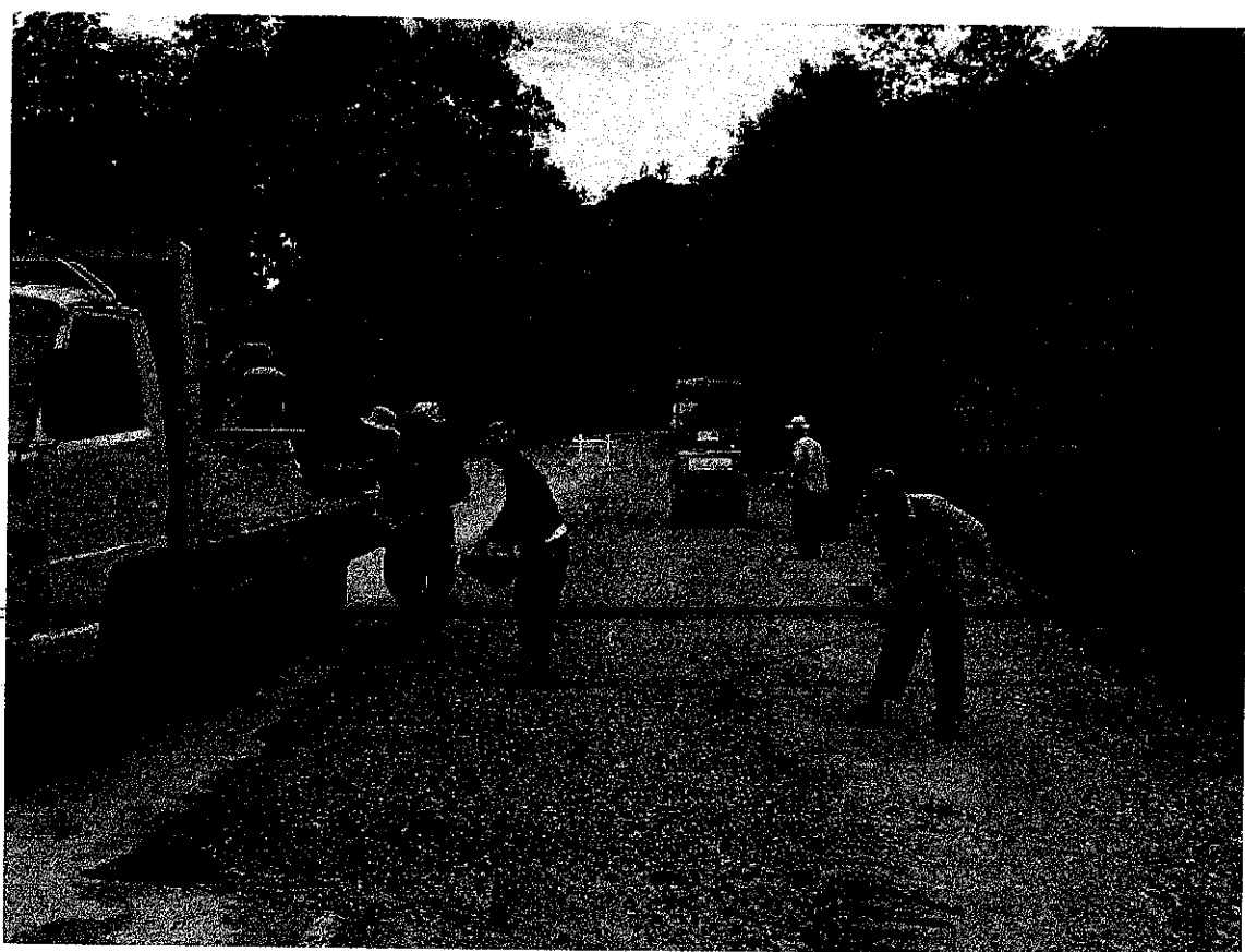
งานซ่อมผิวทางเดิม ทางหลวงหมายเลข 105 ตอน ดาก-แม่สอด (กม. 131+025)
