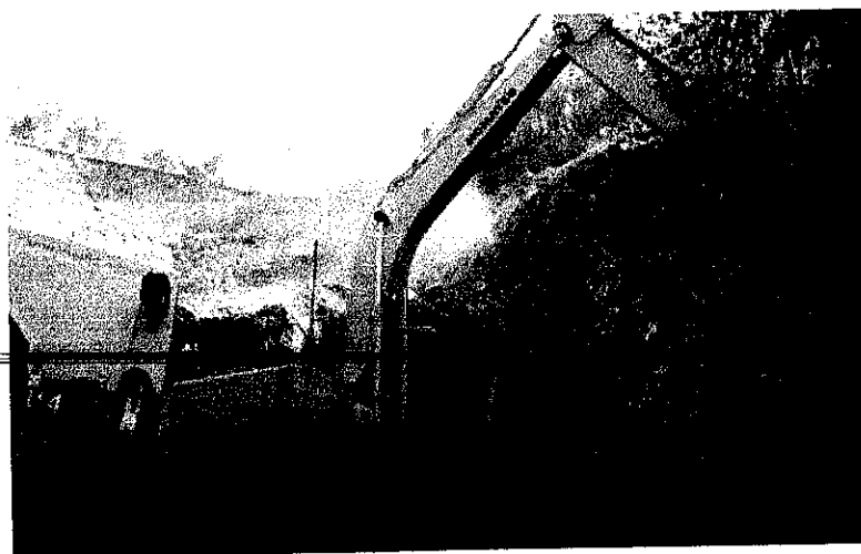
รูปที่ 18 การปรับแต่งพื้นที่เพื่อจะทำการวางกล่องและบดอัด
