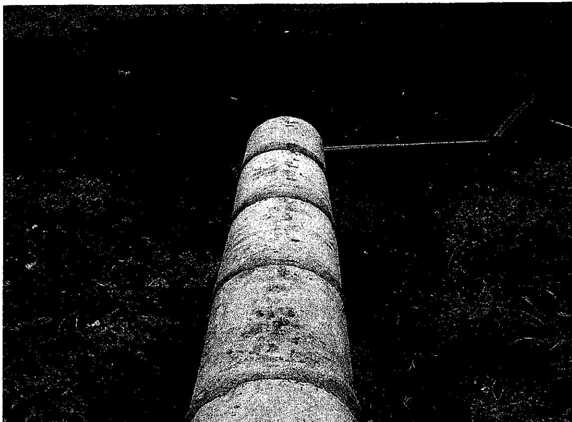
งานขุดวางท่อระบายน้ำ ทางหลวงหมายเลข 1090 ตอน แม่สอด - อู้มผาง (กม.25+350 - 27+100)
