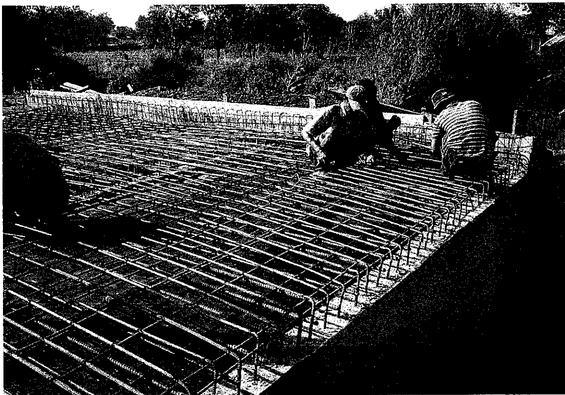
งานก่อสร้างสะพาน ทางหลวงหมายเลข 1090 ตอน แม่สอด - อู่ผึ้ง (กม.25+350 - 27+100)
