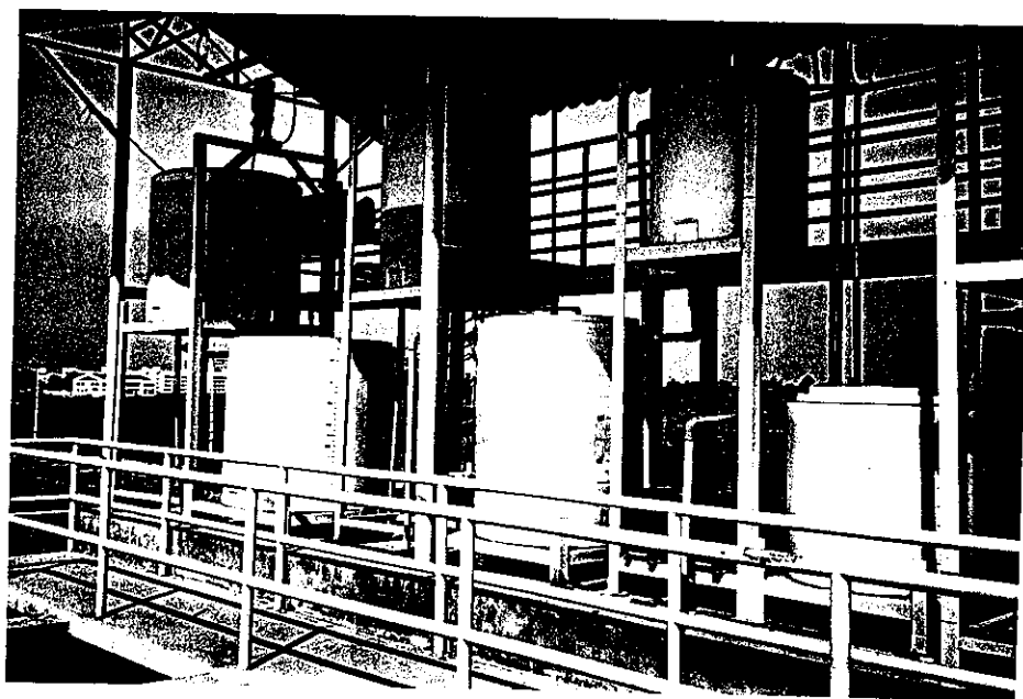
รูปที่ ง.8 แสดงตำแหน่งการวางถังน้ำใส และถังกวนคลอรีน
